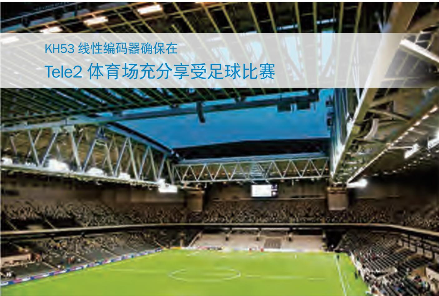
位于瑞典斯德哥尔摩的 Tele2 体育场是一个配备可伸缩屋顶的体育场。这样做的好处是对于在体育场和电视机前的观众来说：当屋顶完全打开时，在运动场上没有阴影。此外，该体育场可用于音乐会，甚至冰球比赛。来自德国 SICK 的 POMUX®KH53 线性编码器可以在打开或关闭屋顶时帮助确定屋顶半球的确切位置。
