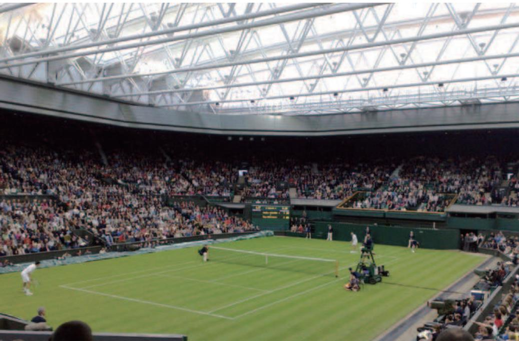
温布敦中心球场的移动式屋顶，有十座长 77 公尺，重达 100 吨移动式屋顶钢梁。能够准确移动这些钢梁的关键是因为采用 SICK 精准的线性编码器。
