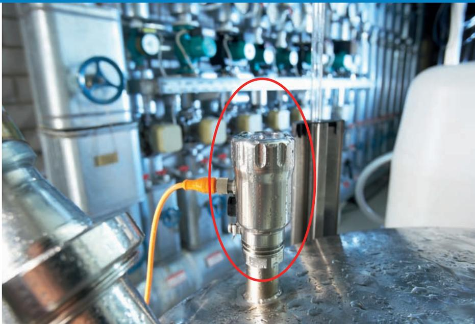
SICK 公司最新的导波雷达型液位计 LFP Cubic，兼具最大程度的灵活性和测量精度。基于 IO-Link 的通讯接口，传感器为自动化现场的液位测量提供了卓越的性能，更加易于系统集成。
